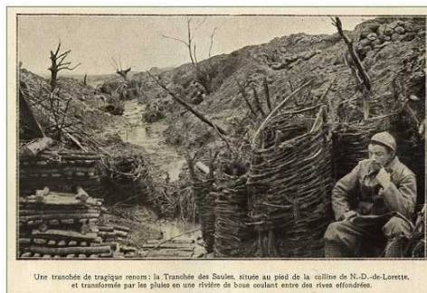
Une tranchée de tragique renom : la Tranchée des Saules, située au pied de la colline de N.-D.-de-Lorette, et transformée par les pluies en une rivière de boue coulant entre des rives effondrées.
